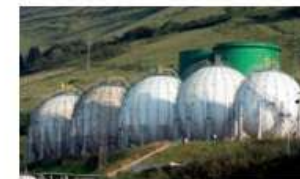
Depósitos de gas.
