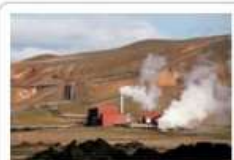
Central geotérmica en Islandia. El vapor generado en las zonas volcánicas puede aprovecharse para obtener energía eléctrica.
