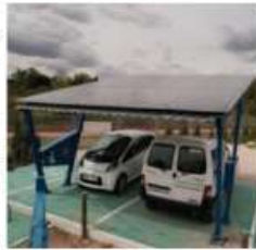
Fotolinera de Alcalá de Henares. Genera 3,6 kW-h. Permite cargar las baterías de cuatro vehículos simultáneamente.
